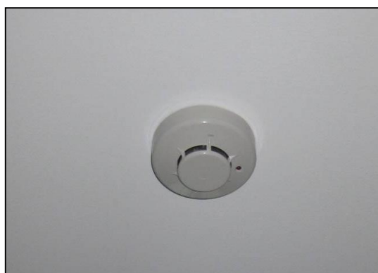
ภาพที่ 1-9 อุปกรณ์ตรวจจับความร้อนและอุปกรณ์ตรวจจับควัน
