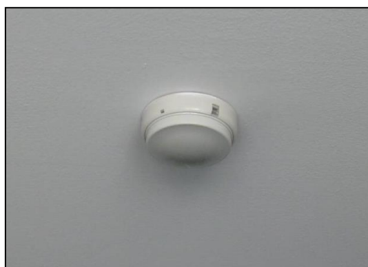
ภาพที่ 1-9 อุปกรณ์ตรวจจับความร้อนและอุปกรณ์ตรวจจับควัน
